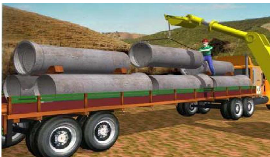
Figura 11 – Descarregamento das tubulações
