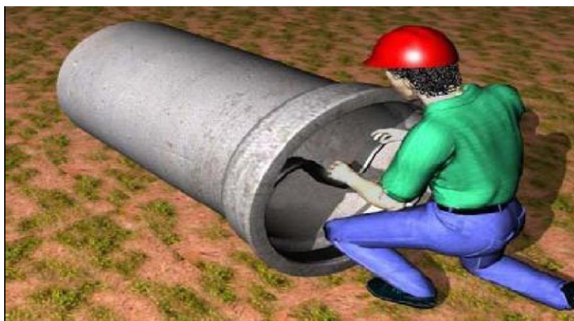
Figura 13 - Colocação do anel de borracha
